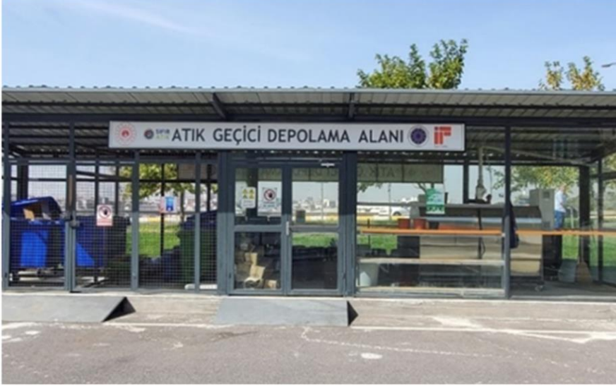
Atık Geçici Depolama Alanı
